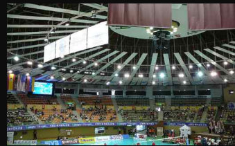
수원실내체육관 건축/전기음향 개선 컨설팅 (2015)
